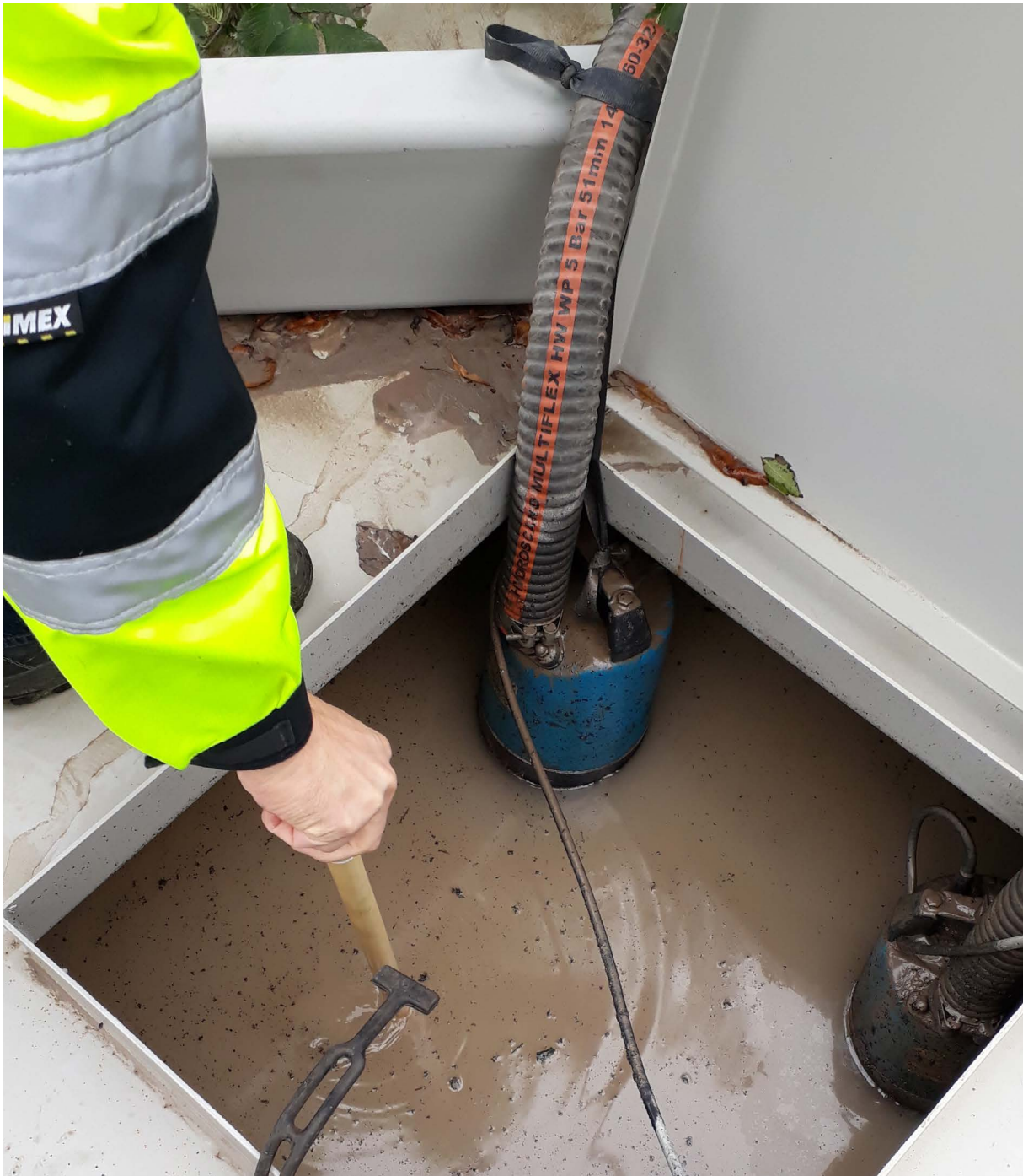
Kuva 15: Laskeutusaltaaseen kertyneen sedimentin määrää selvitetään kokeilemalla altaan pohjaa kepillä. Saara Olsen
