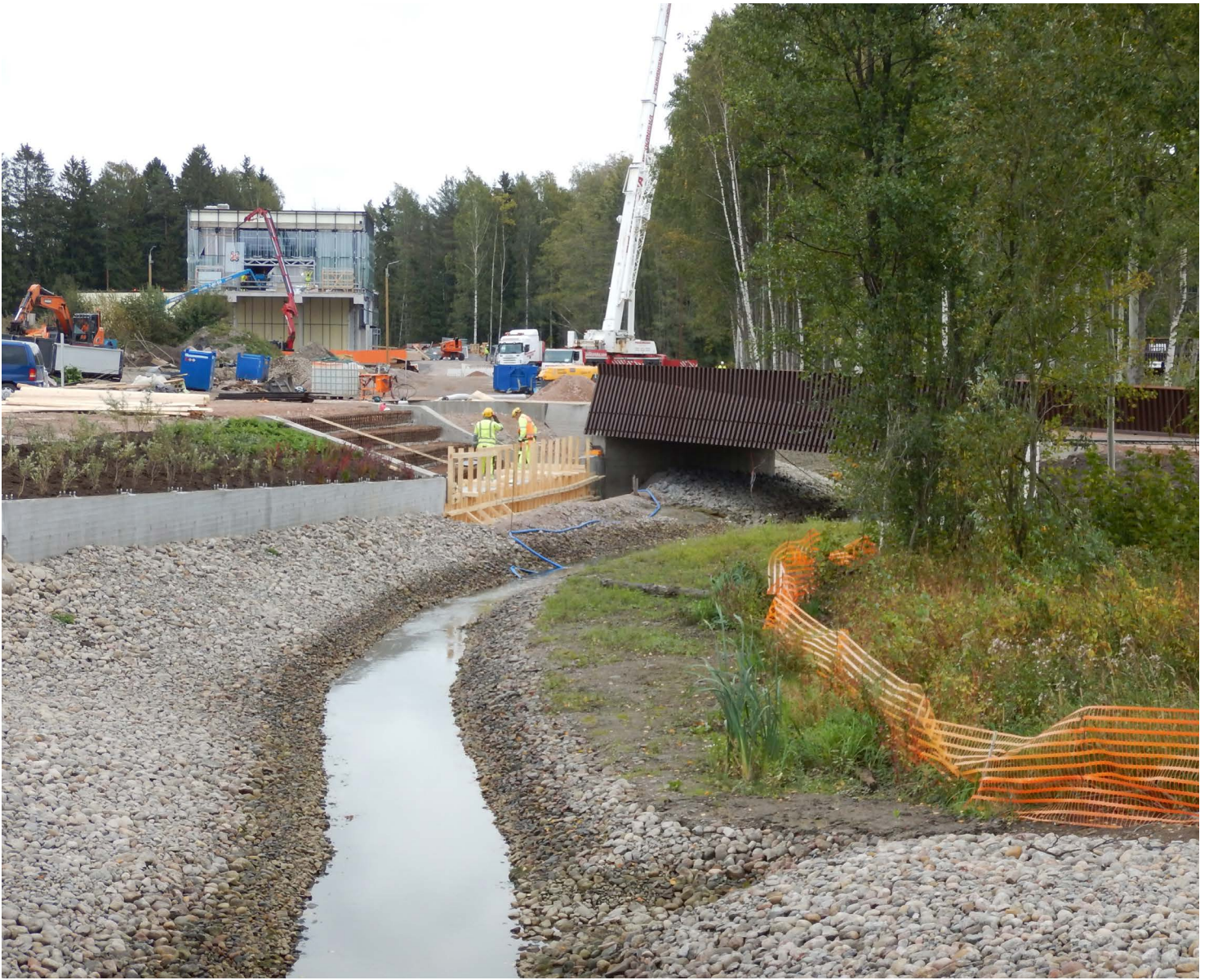
Kuva 1: Työmaa, jossa uoman penkat on eroosiosuojattu ja uoman varrelle jätetty maata sitovaa ja huuhtoutumista estävää kasvillisuutta. Saara Olsen
