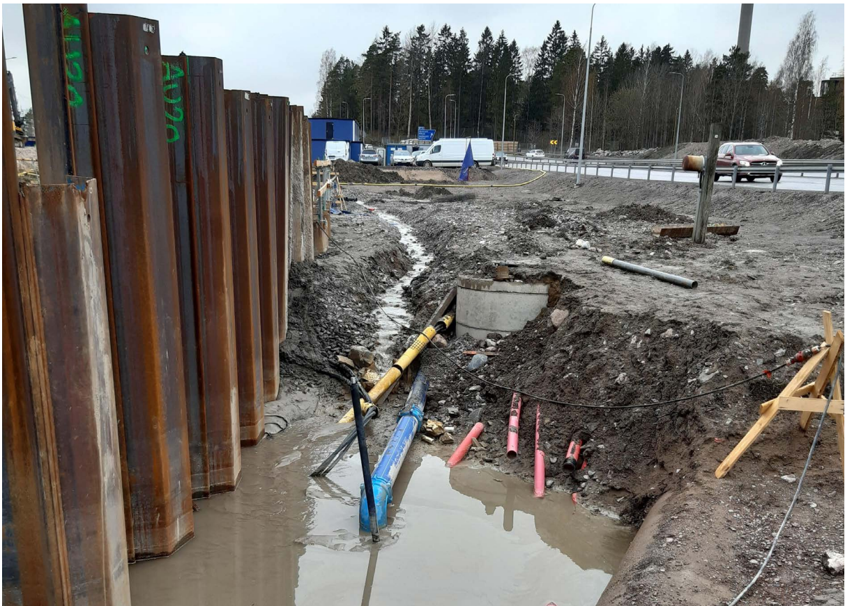
Kuva 3: Työmaakaivanto, jossa pumppu. Saara Olsen
